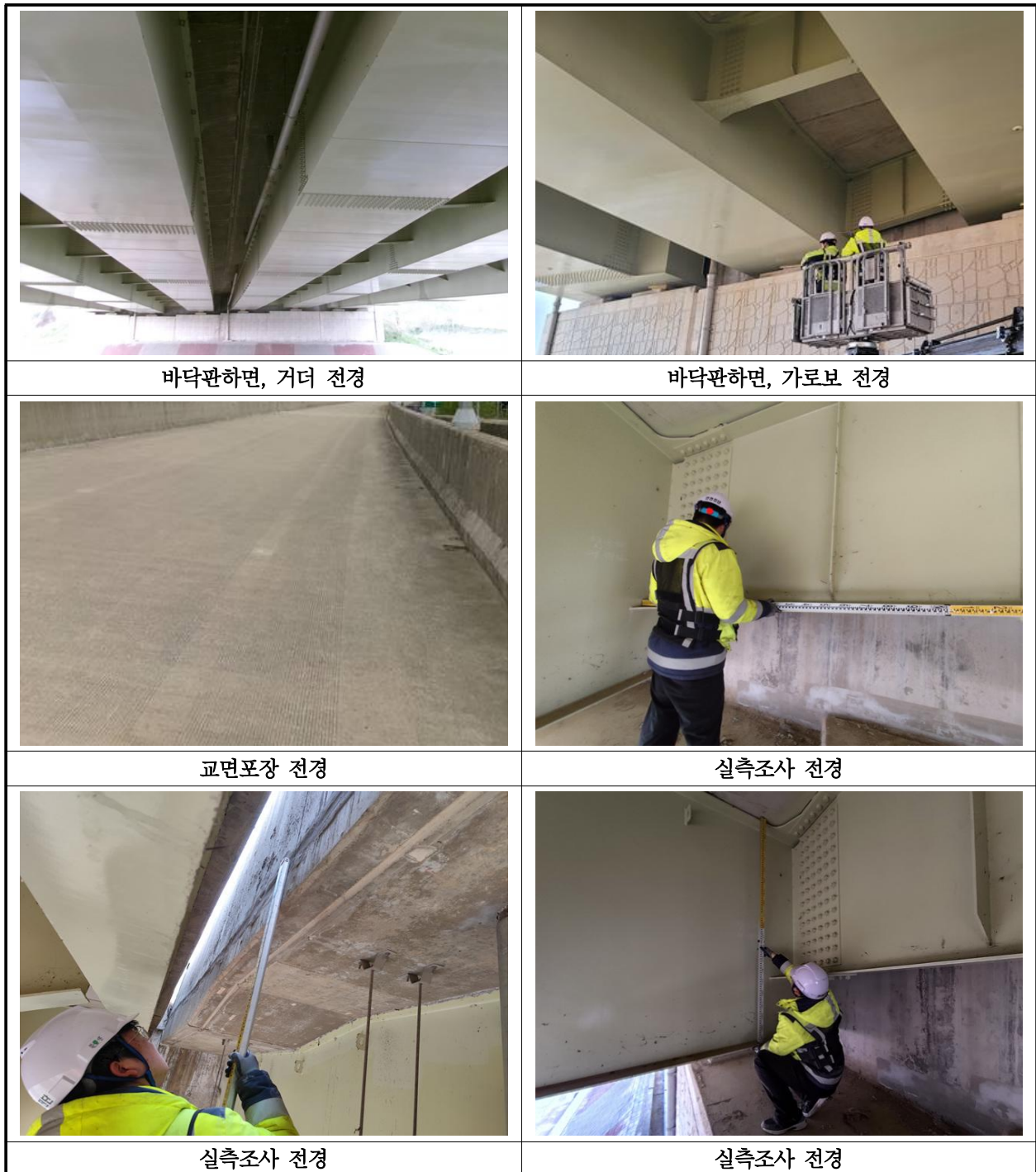
【사진 2.2.2】 상부구조 현황
