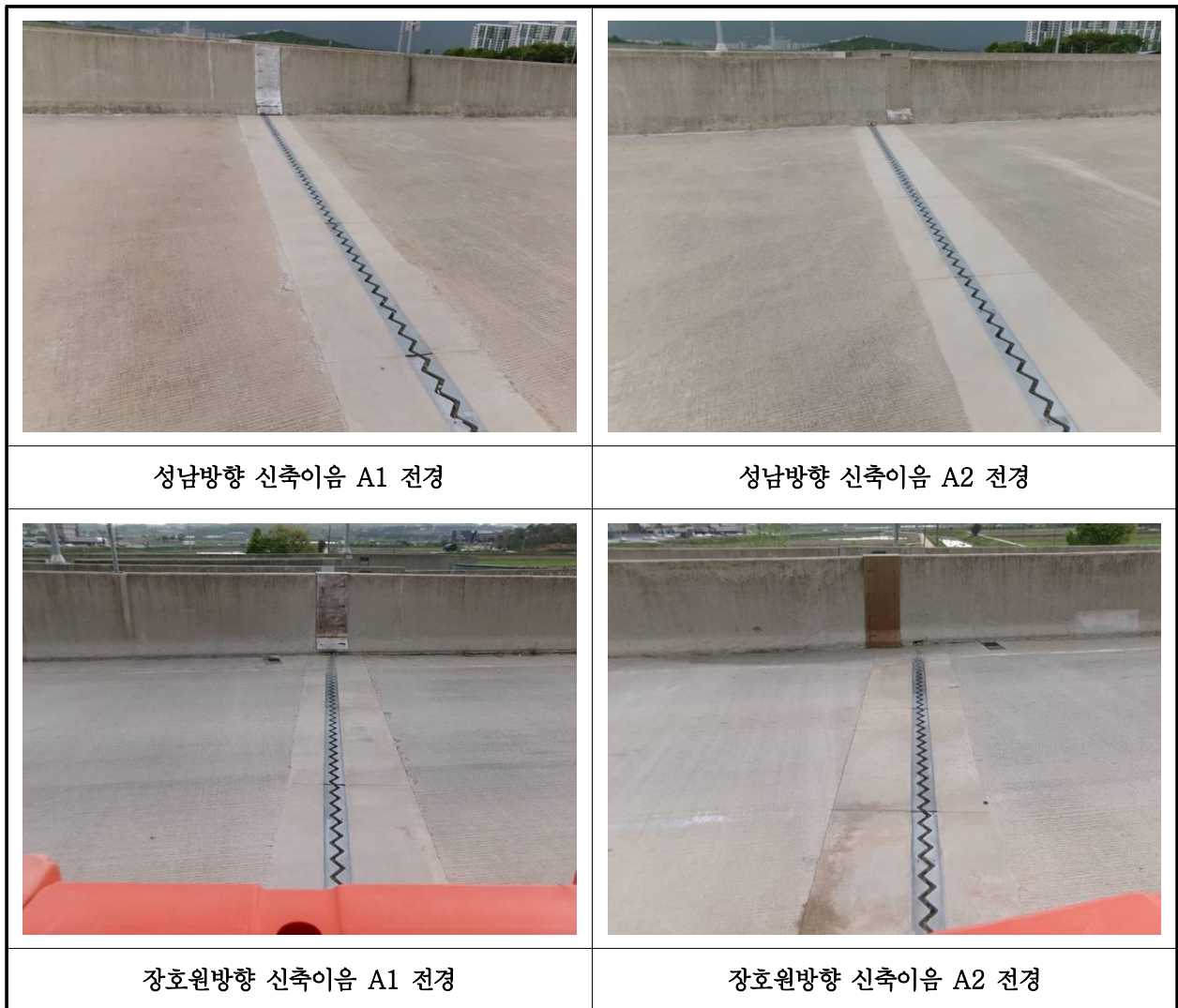
【사진 2.2.3】 신축이음장치 현황
