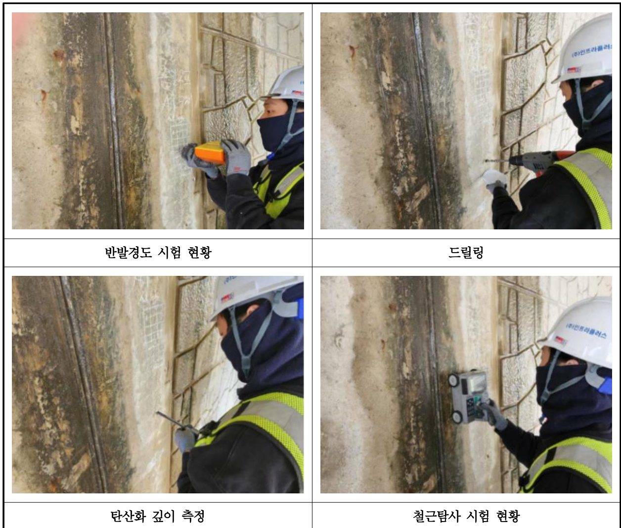
【사진 2.3.1】 콘크리트 내구성조사 현황
